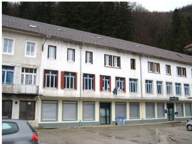
Centre administratif rue de l'Industrie
