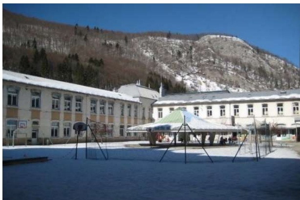
L'école du Centre après abandon du mur de séparation garçons-filles
